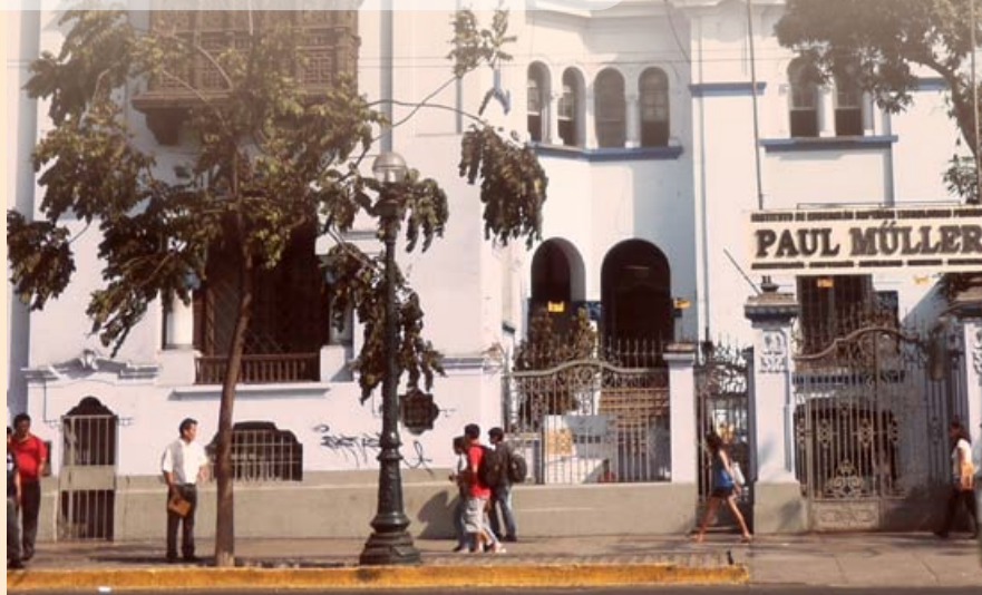
Local de Paseo Colón está dentro de zona histórica de Lima.
